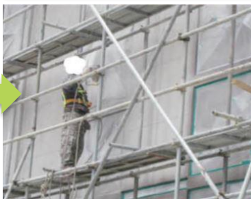
안전난간대 2단 설치
