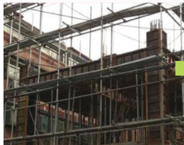
작업발판 단부 안전난간대 미설치
