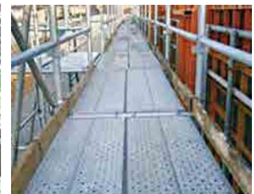
시스템 비계 설치
