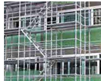
시스템 비계 설치
